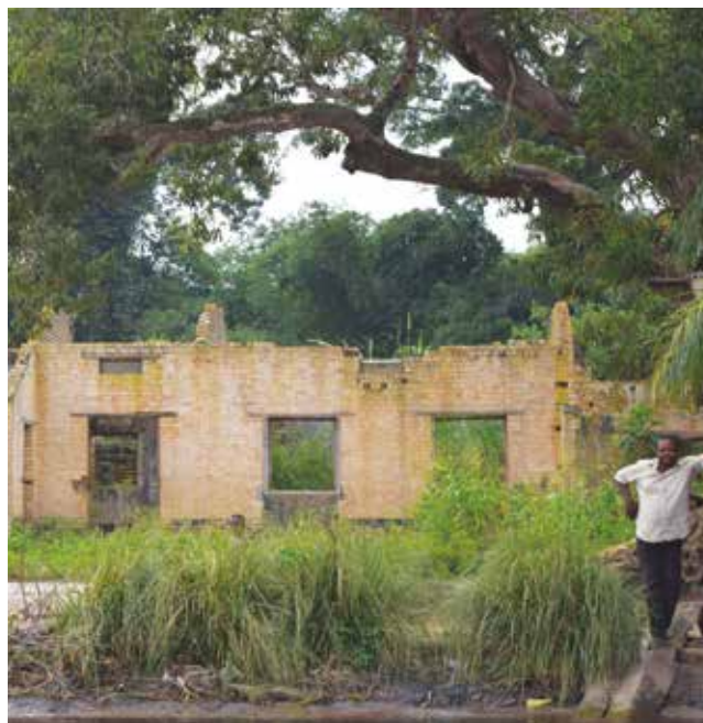
Ruines coloniales dans un village de la province de l'Équateur
